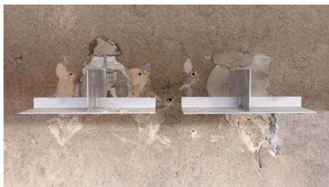
Bild oben: JMK+ P Konsole Montage
