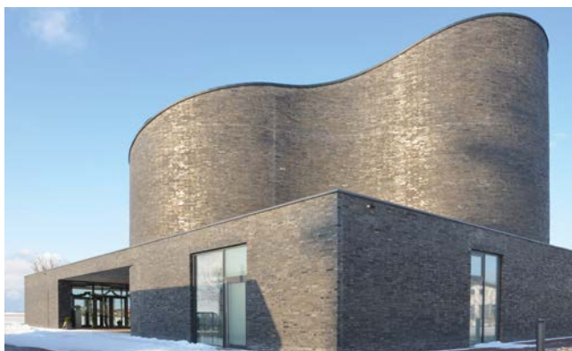
St.-Marien-Kirche zu Schillig: Eine besondere Herausforderung bildeten die geschwungenen Formen des Bauwerks, die bei der Konsolenplanung durch die JORDAHL Experten berücksichtigt wurden.
