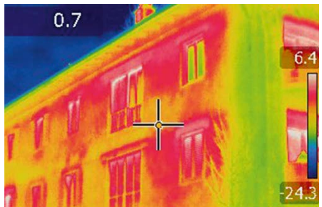
Visualisierung von Wärmebrücken mittels Thermografie
