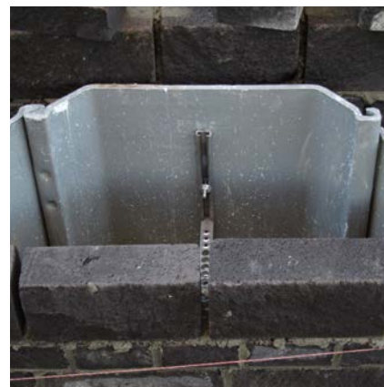
Anschluss von Verblendmauerwerk an Stahlbetonbauteile
